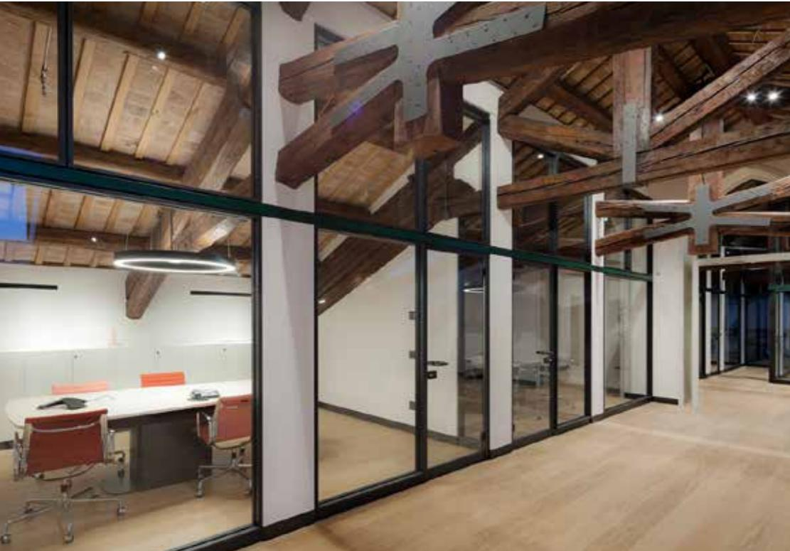
*Il sottotetto è stato ricavato dalla mansarda modificando le travi originali.*
