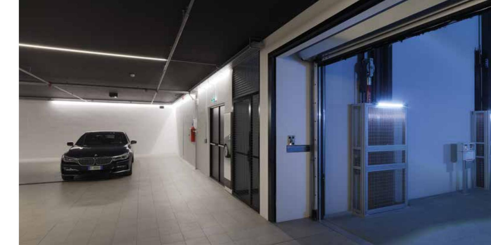
Lungo le pareti di servizio al piano interrato Glip ha installato GS 20 su profilo dissipante alto 3000°K cri>90.
